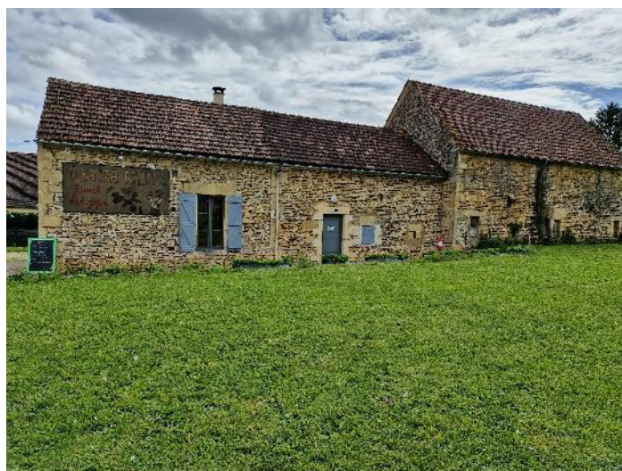
Façade Nord, partie boulangerie et toilettes publiques
