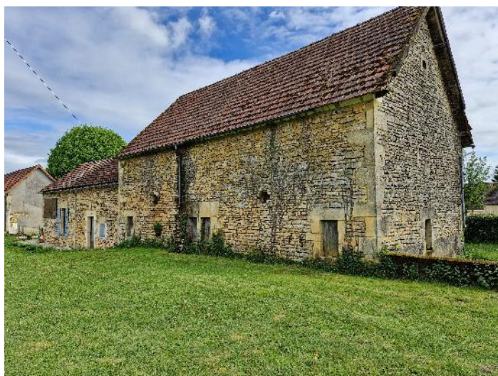
Façade Nord et pignon Ouest – partie objet de l'AMI
